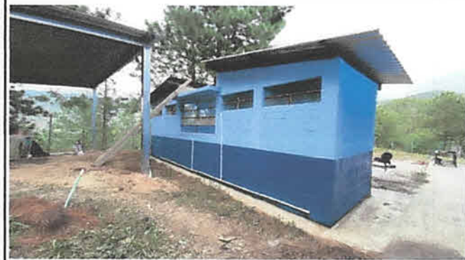
Foto 4: Restauración de sistema hidráulico.
