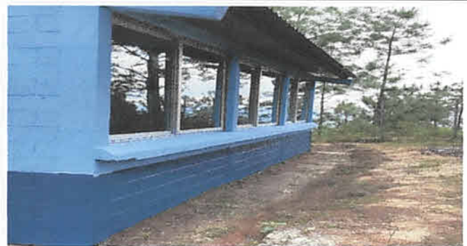
Foto 4: Instalación de ventanas de PVC
