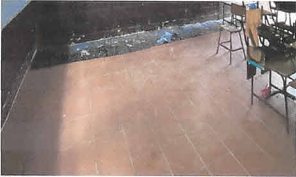
Foto1: Mejorar el piso actual, instalando piso cerámico.
