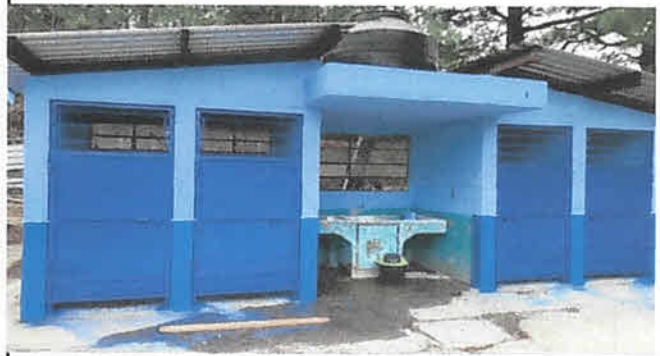
Foto 2: Restauración de servicios sanitarios.
